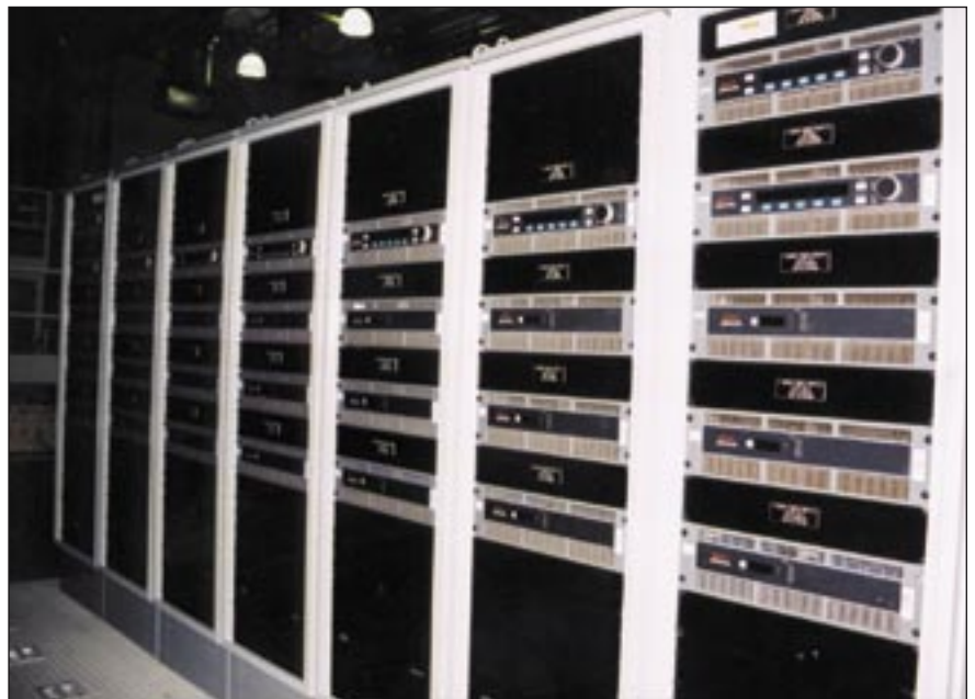
用於主/從配置的 Pinnacle 電源機架(照片版權所有 2002 Southwall® Inc.,已獲准在此處使用)
